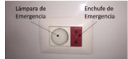
A un costado del enchufe rojo, se encuentra una lámpara de emergencia extraíble marca BTicino Art. A5780N, la cual se enciende automáticamente ante un corte de energía. El código para el reemplazo de la batería es BTicino Art. 4380NB.
